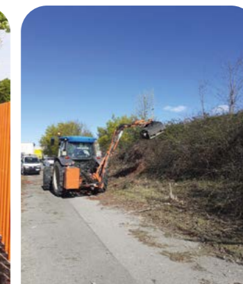
Lavori alle "collinette"
