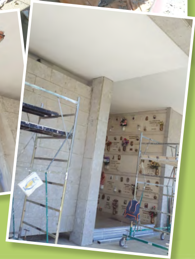
SISTEMAZIONE SFONDELLAMENTO campata cimitero
