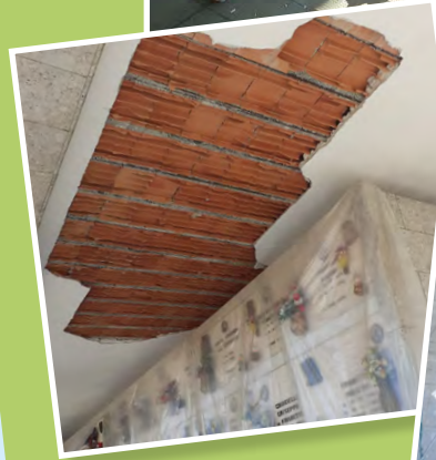
SISTEMAZIONE SFONDELLAMENTO campata cimitero
