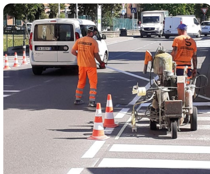
I lavori di rifacimento della segnaletica orizzontale
