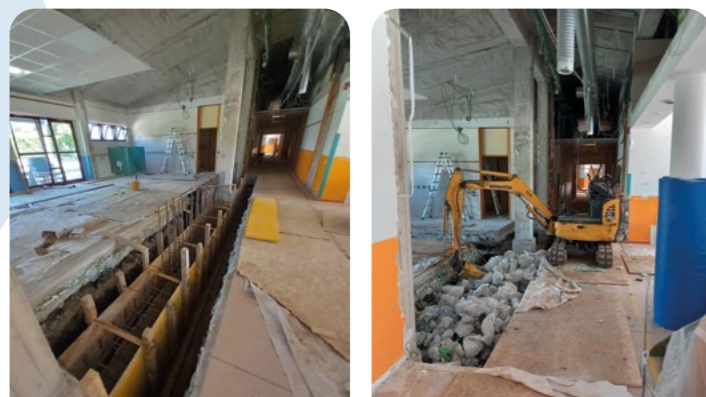
Messa in sicurezza sismica alla scuola dell'infanzia
