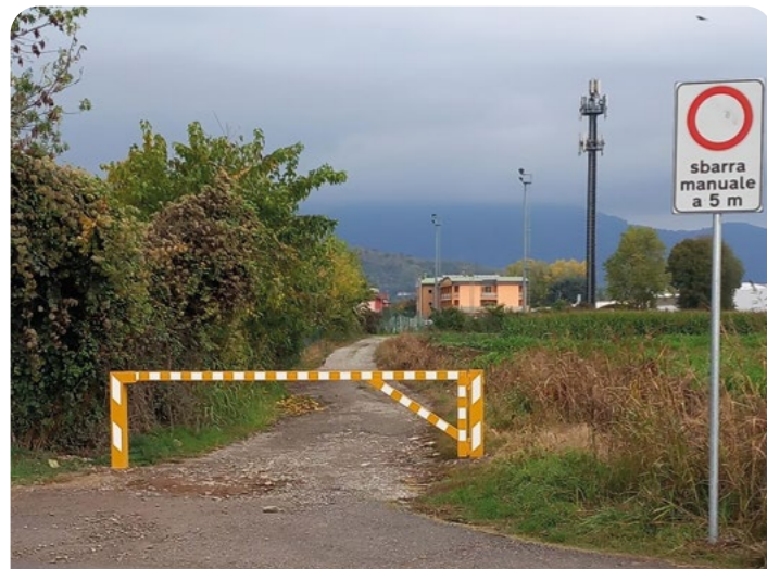
La sbarra installata all'ingresso di via Carbonera
