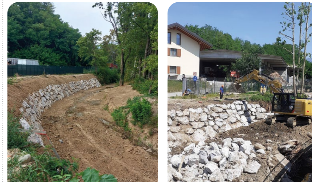
Lavori di messa in sicurezza idraulica del Buliga
