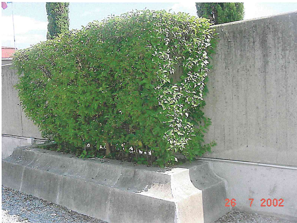
Particolare della recinzione interna , lato est.
