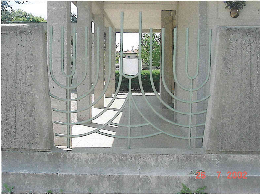
Particolare della recinzione sul lato est.
