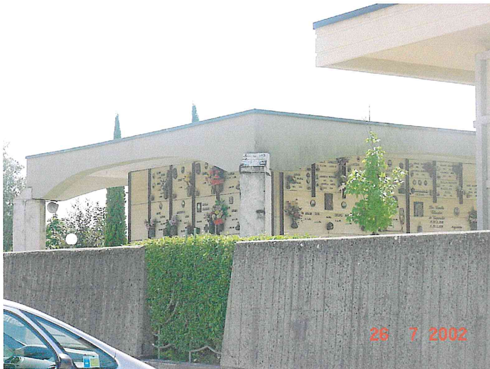
Vista particolare della recinzione ad est.
