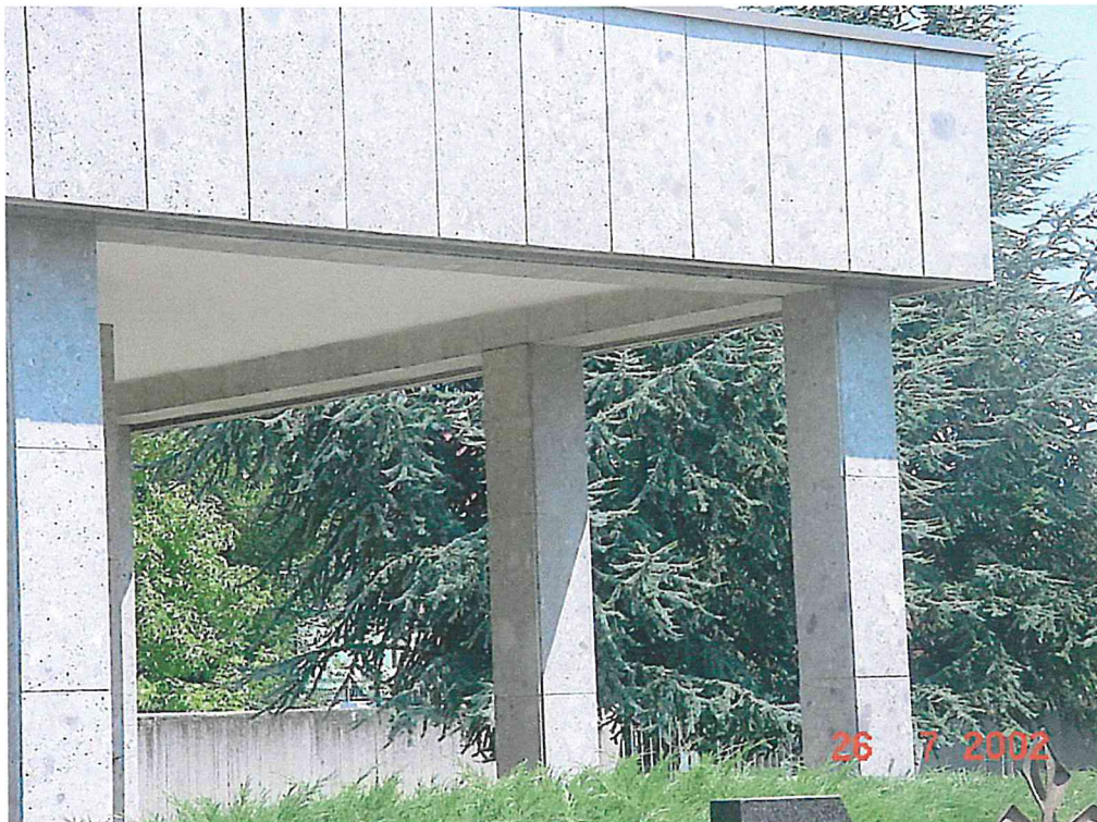
Particolare della copertura dei loculi ad est.
